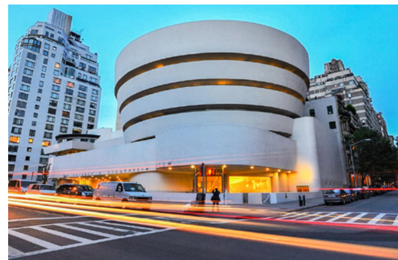
Iluminación Guggenheim Museum Nueva York, EUA
